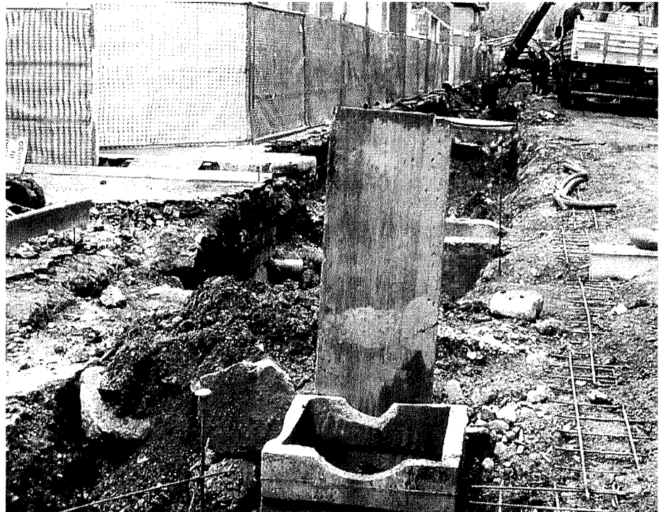
Un cantiere a Roma (foto TOIATI/FABIANO)
